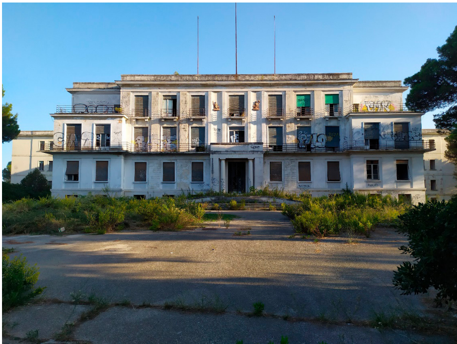
Figura 2. Ex Sanatorio A. Galateo – Stato di fatto dell'ingresso principale
